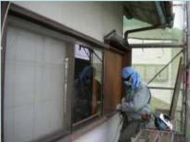
サッシ撤去 上レールの板金水切りをバールを使って撤去(サンダーカット後)
