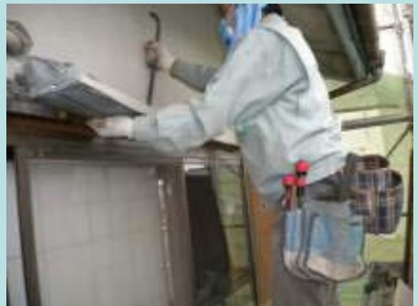
内付けサッシ撤去後、戸袋枠撤去
